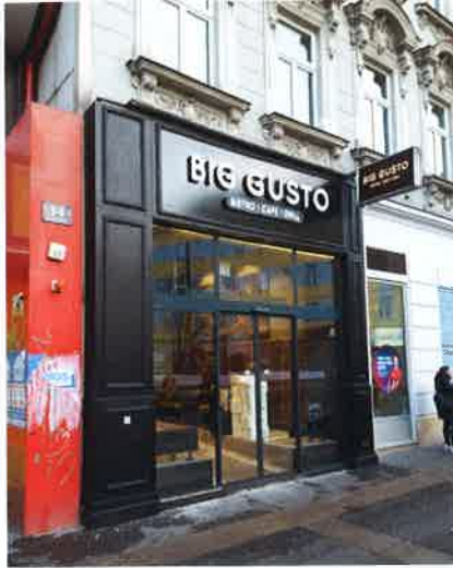
Strukturwandel Beispiel 1: Einst ritt hier John Wayne hoch zu Ross über die Leinwand. Das Kepler-Kino ist aber mittlerweile Geschichte und machte Platz für das Bistro und Café Big Gusto.
