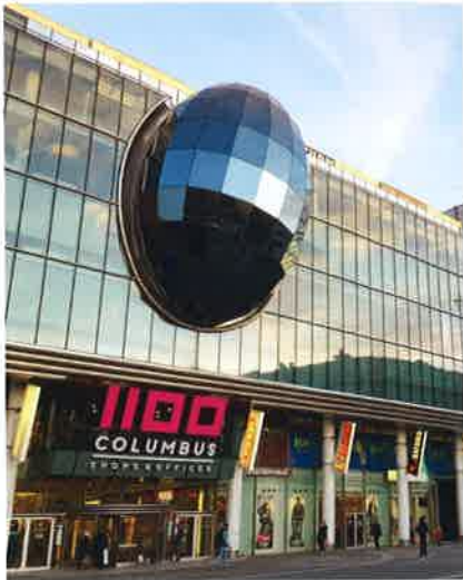
Das 2005 eröffnete Columbus Center wechselte kürzlich den Eigentümer und wurde im Vorjahr vom neuen Center und Property Manager EHL Immobilien als „1100 Columbus“ neu positioniert.
